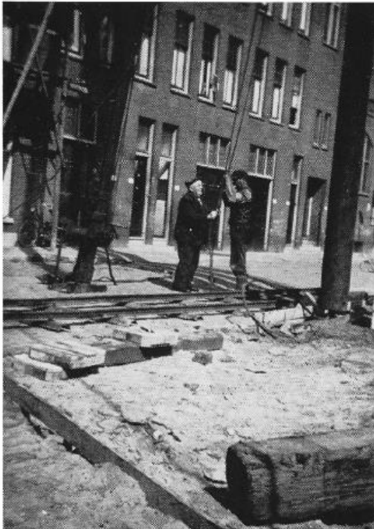
Broeder M. Kropff helpt bij het slaan van de eerste paal van het eerste eigen kerkgebouw "Eben Haëzer".
